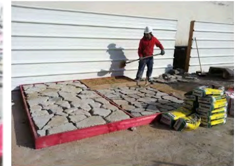
Prototypage d'un opus incertum en béton réemployé
