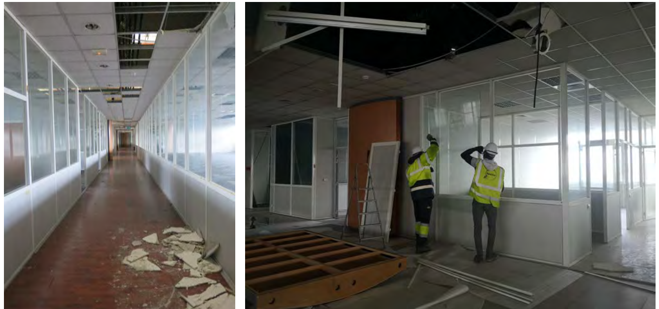
Chantier de dépose soignée dans le bâtiment du CNAP
