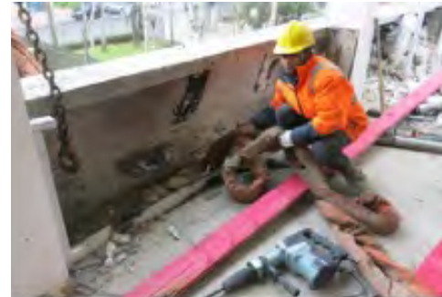
Test de dépose d'une allège préfabriquée – Montrouge. Entreprise : Doyère démolition
