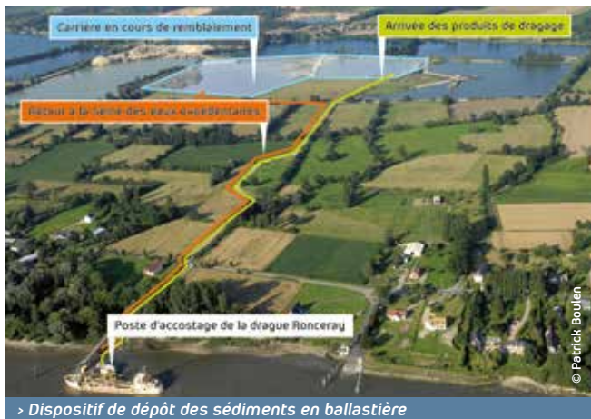
> Dispositif de dépôt des sédiments en ballastière
