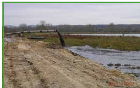
Déversement de la tourbe par voie hydraulique (automne 2007)
